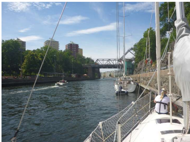
Kuva 3 - Danviksbron avauksen odottamista. Avataan tasatunnein.
